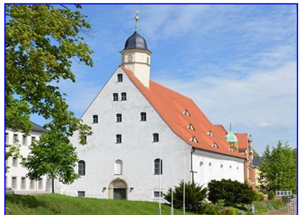
Kath. Pfarrkirche St. Johannis in Freiberg
